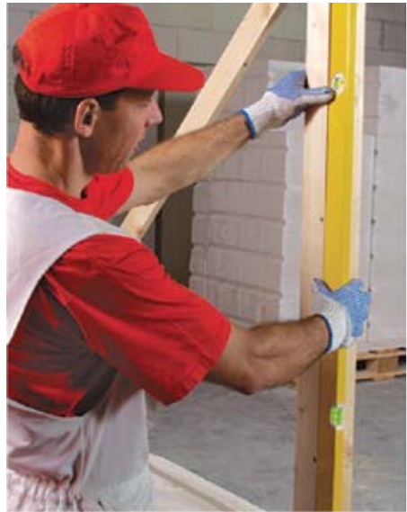
Установите рейки вертикально таким образом, чтобы четко обозначить ими углы кладки (рис. 5.23).
