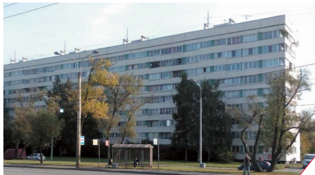
Наружные стены из автоклавного газобетона. «Корабль», 1970-е, Санкт-Петербург
